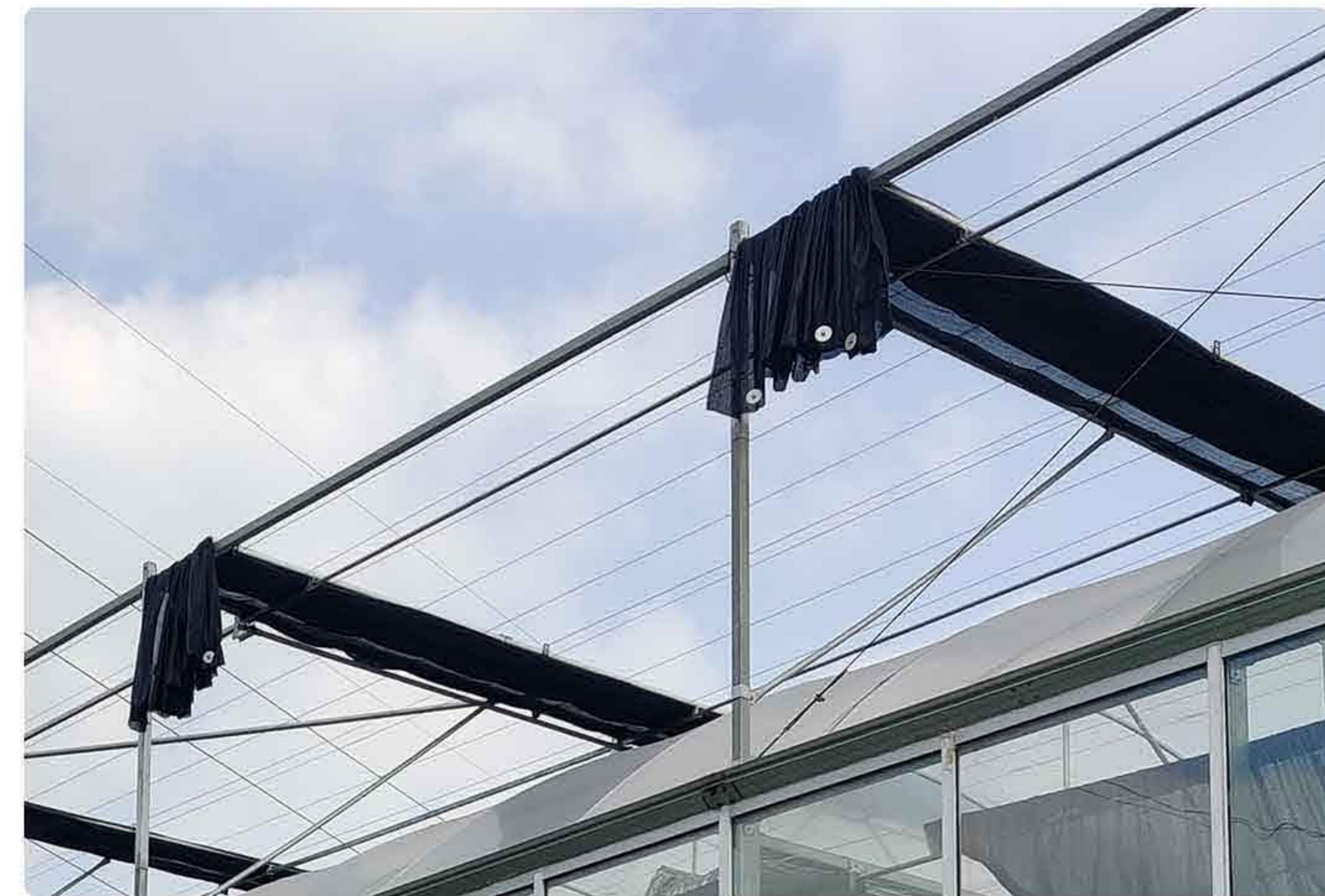
遮阳系统分外遮阳、内遮阳和内保温系统。系统主要功能有：夏季遮阳、降温；冬季保暖。通过选用不同遮阳率的幕布，以满足不同作物对阳光的需求。针织网、百吉网，多门贯穿织法，抗脆化，强拉力，耐磨，耐撕，经久耐用，排齿机械转动性能稳定、平整、严密，可依光度时间设定。控制颜色有：黑色、绿色、透明。
